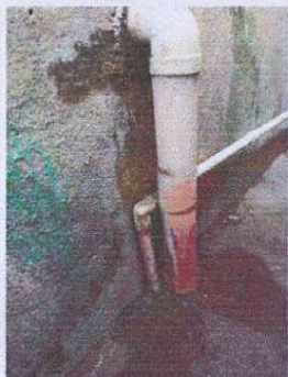
Foto 1: REPARACION DE RED DE DRENAJES DE AGUAS GRISES.
