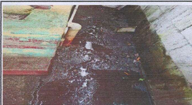
Foto 4: REPARACION DE RED DE DRENAJES POR TUVO PVC DE 3".
